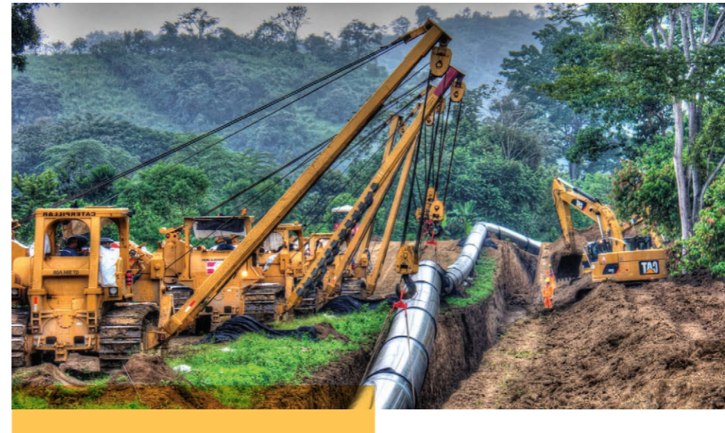
La Esperanza Aqueduct - Ecuador
