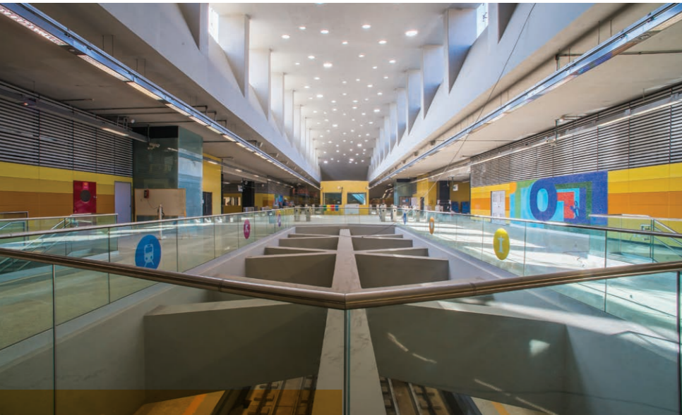
Tubular Solar Lighting, Jardim Oceânico Station, Rio de Janeiro - Brazil
